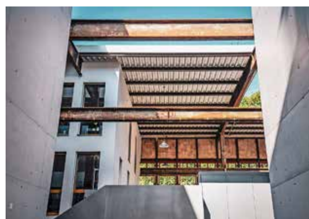
Neubauten, harmonisch zwischen Stahlträgern eingefügt.
