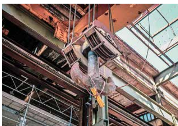
Die alten Kräne mit ihren Bahnschienen – weiterhin sichtbar.
