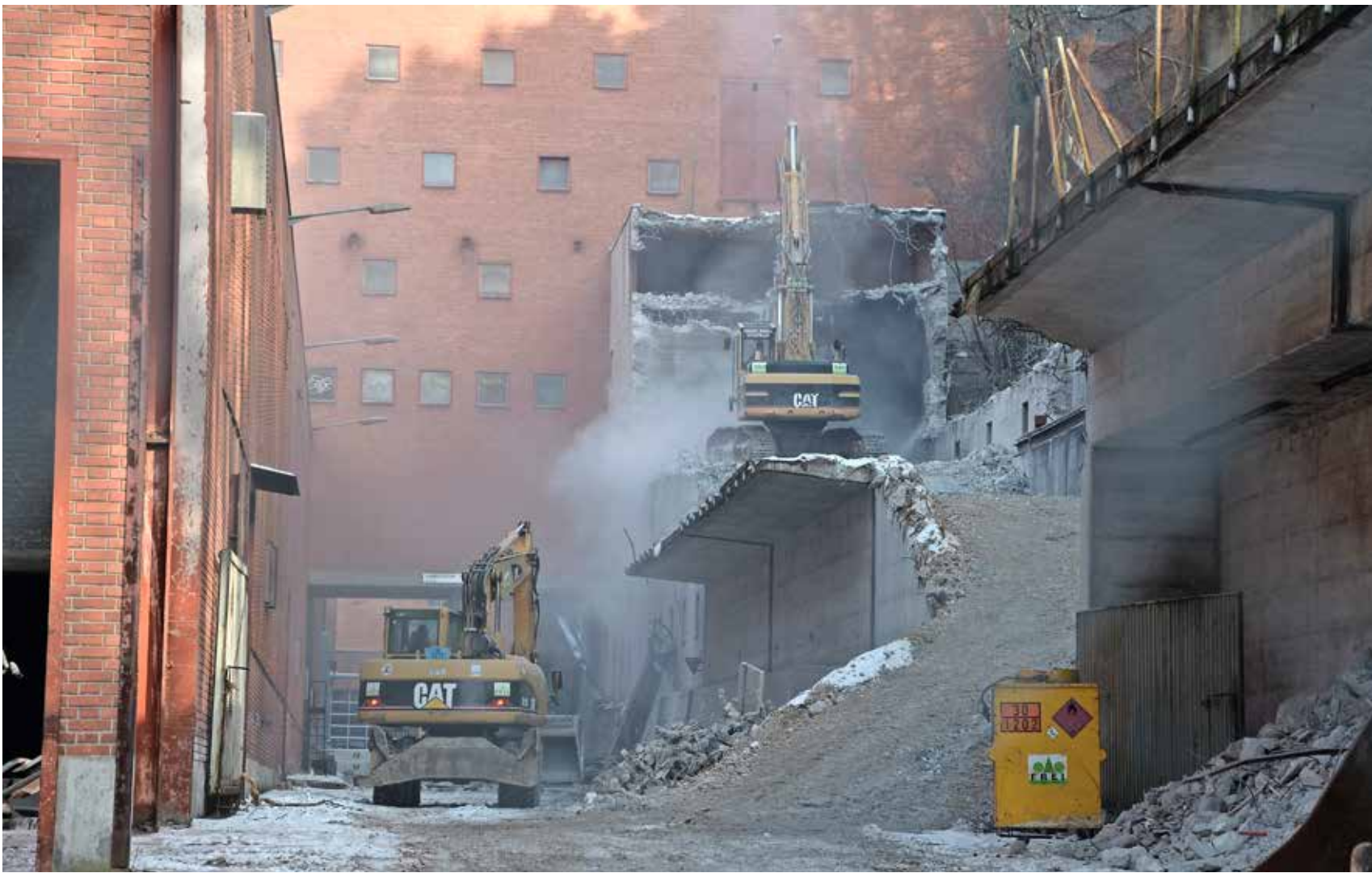
Auf dem Gelände der ehemaligen Stahlgießerei von Georg Fischer im Mühlental haben die Bauarbeiten begonnen. Zunächst muss das einstige Hochlager (im Bild das Gemäuer rechts) abgerissen werden. Etwa an dieser Stelle wird künftig eine Betonmauer zur Hangsicherung dienen. Bild Maria Gerhard
