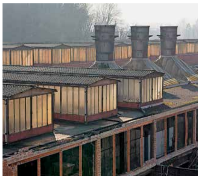
Auch die Dächer gibt es bald nicht mehr. Die Schlotte waren zum Abzug direkt über den Schmelztiegeln angebracht.
