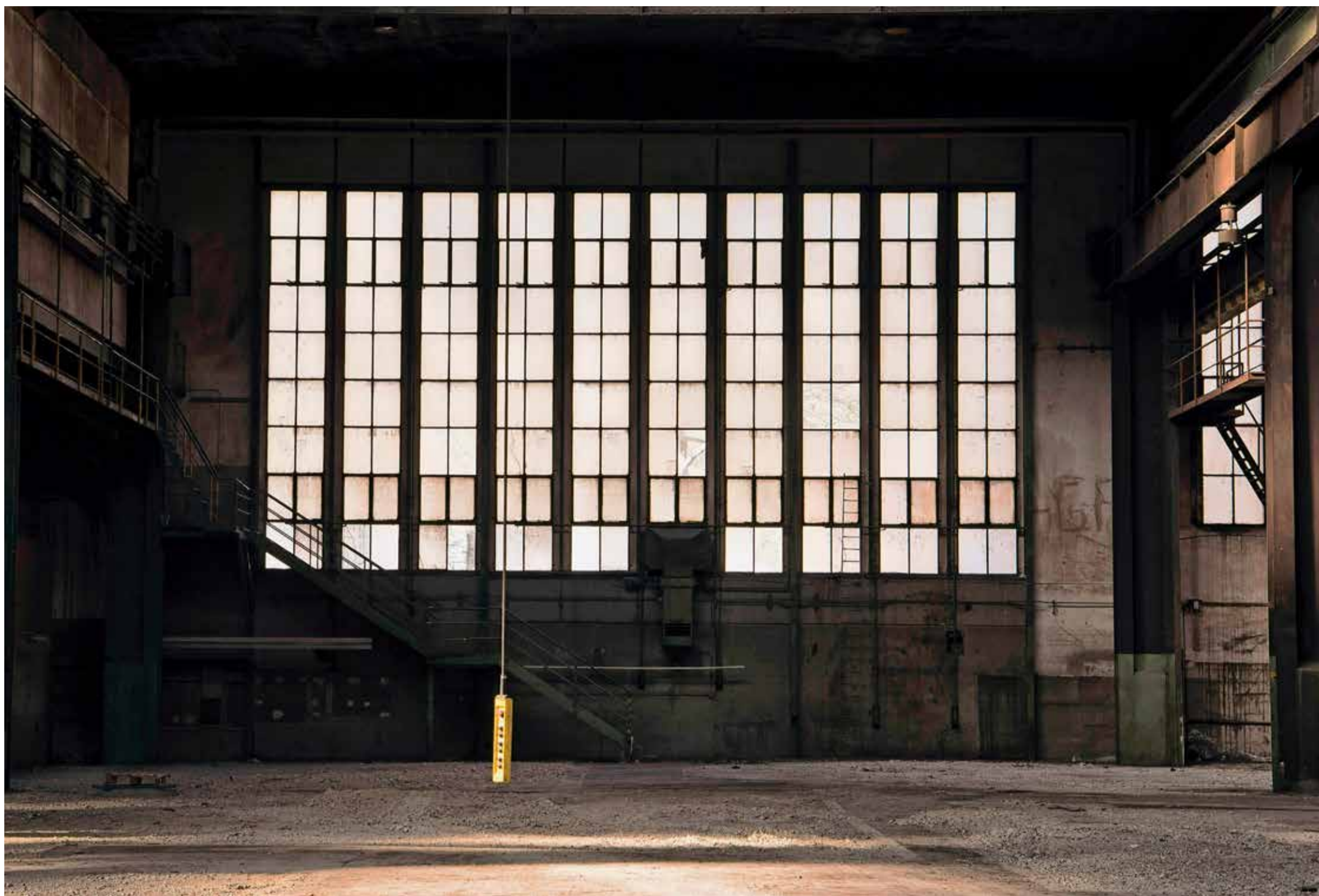
Das Pendel steht ganz still: In diesem Fall handelt es sich jedoch um die einstige Schaltanlage für einen Kran in einer der Lagerhallen der alten Georg-Fischer-Stahlgiesserei im Mühlental.
