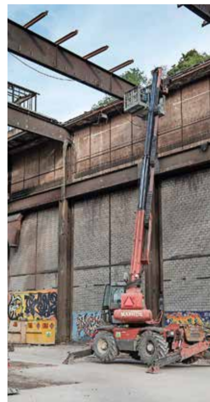
Der Kran wird genutzt, um das restliche Dach abzumontieren.
