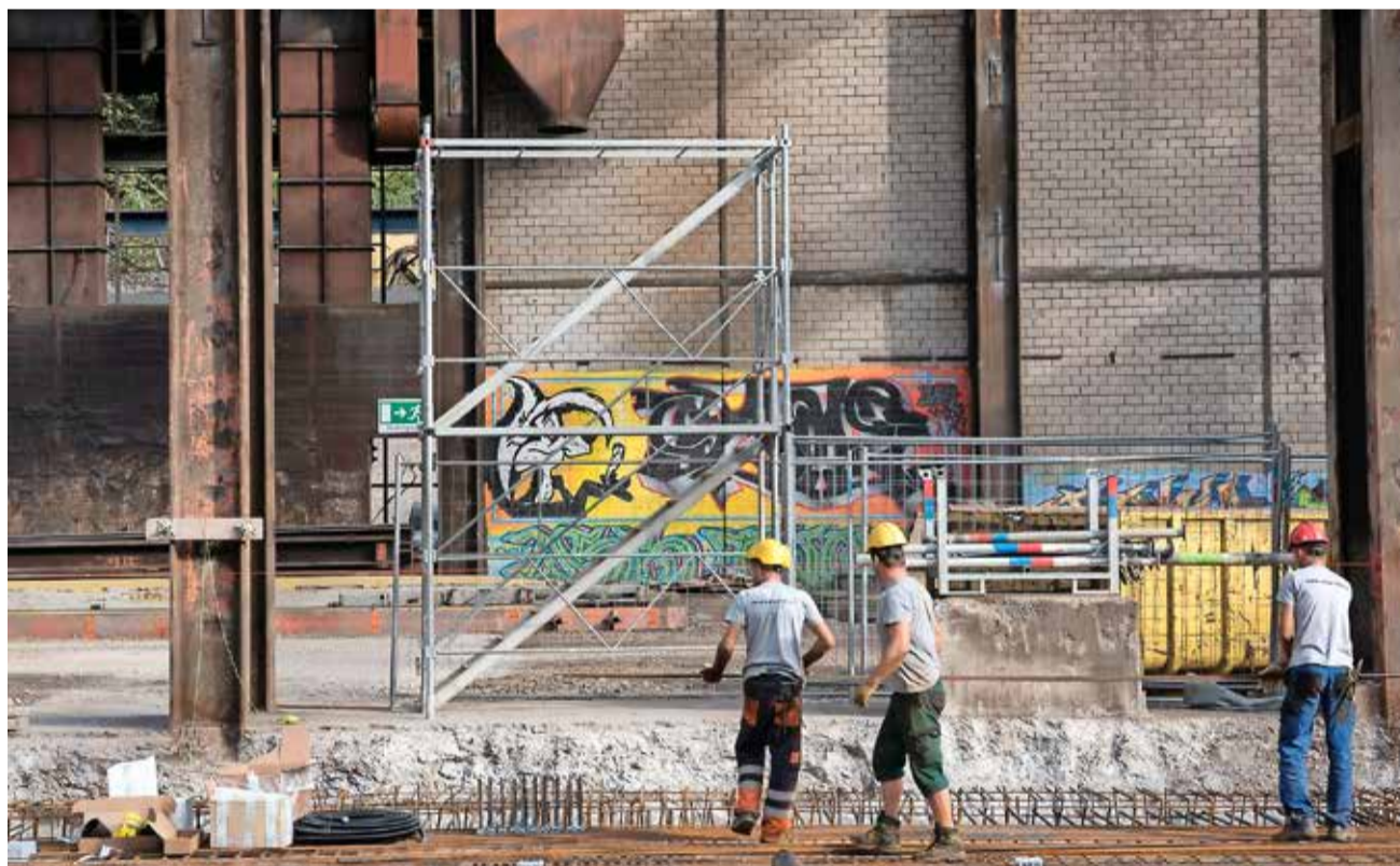
Die Graffiti im Hintergrund werden wohl kaum erhalten bleiben. Doch zunächst kümmern sich diese Arbeiter darum, dass das Fundament mit Stahlmatten bedeckt wird.
