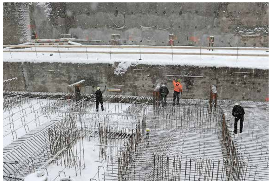
Hier entsteht das Fundament – es soll noch vor Weihnachten fertig werden – für das vierte Hochhaus. Die Bauarbeiter mussten den Schnee gestern Morgen teilweise mit heissem Dampf entfernen.
