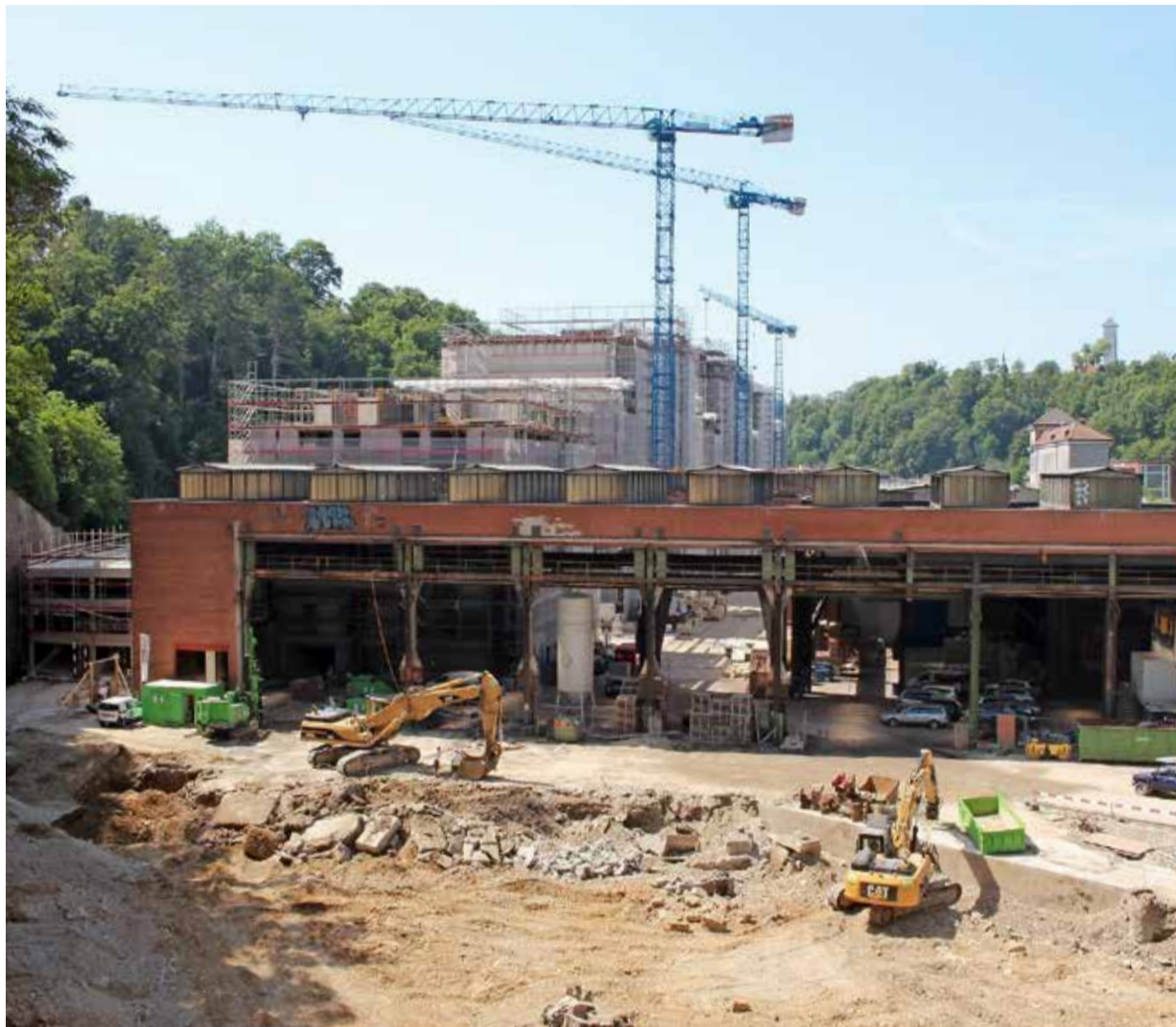
Hier entsteht ein neuer Stadtteil: Die Baustelle der Stahlgiesserei im Mühlental.
