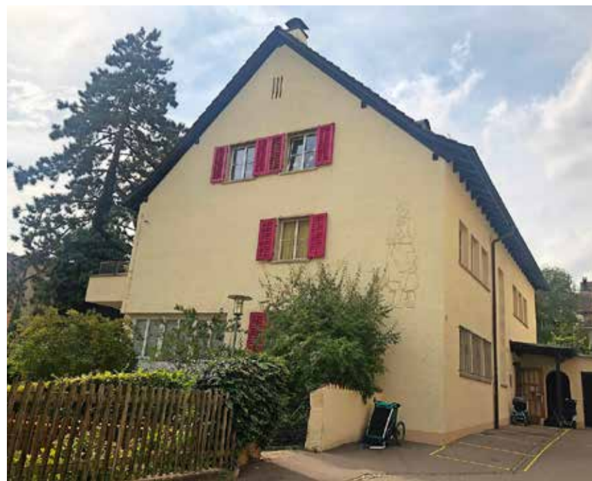
Die Krippe Lebensraum befindet sich in einem sanierungsbedürftigen Gebäude. BILD HEU
